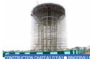
CONSTRUCTION CHATEAU D'EAU ● BINGERVILLE
