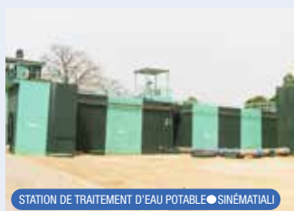
STATION DE TRAITEMENT D'EAU POTABLE ● SINÉMATIALI
