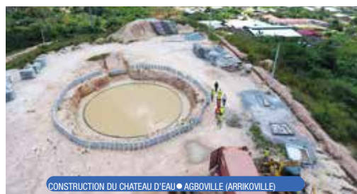
CONSTRUCTION DU CHATEAU D'EAU ● AGBOVILLE (ARRIKOVILLE)
