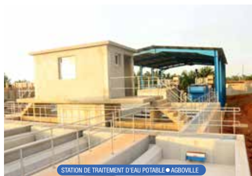
STATION DE TRAITEMENT D'EAU POTABLE ● AGBOVILLE
