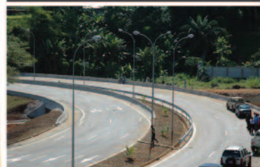
Route de la Corniche après travaux de réhabilitation
