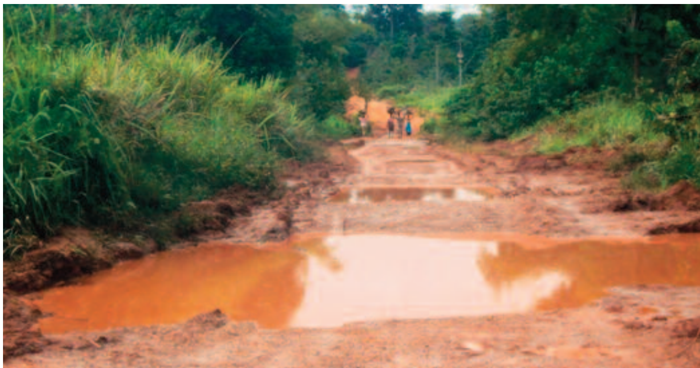
PRI-CI : Composante Réhabilitation des pistes rurales
