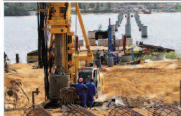
Chantier du Pont de Jacquville
