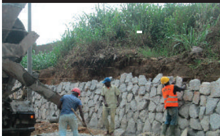
La pose des perrés sur les contre-allées Nord, taux d'exécution 80 %
