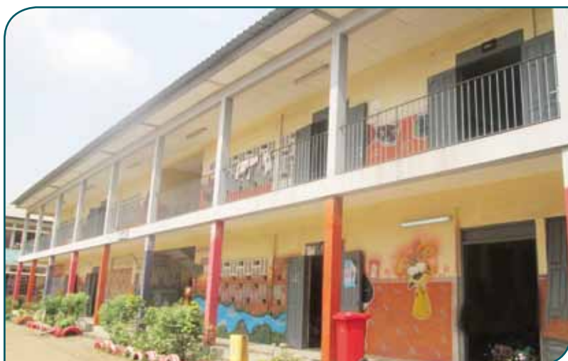
Des latrines supplémentaires construites par le Prici pour répondre aux besoins des élèves.
