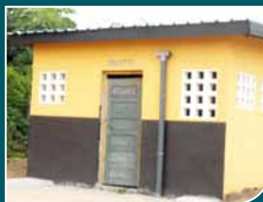
Les latrines après les travaux du Prici ▼
